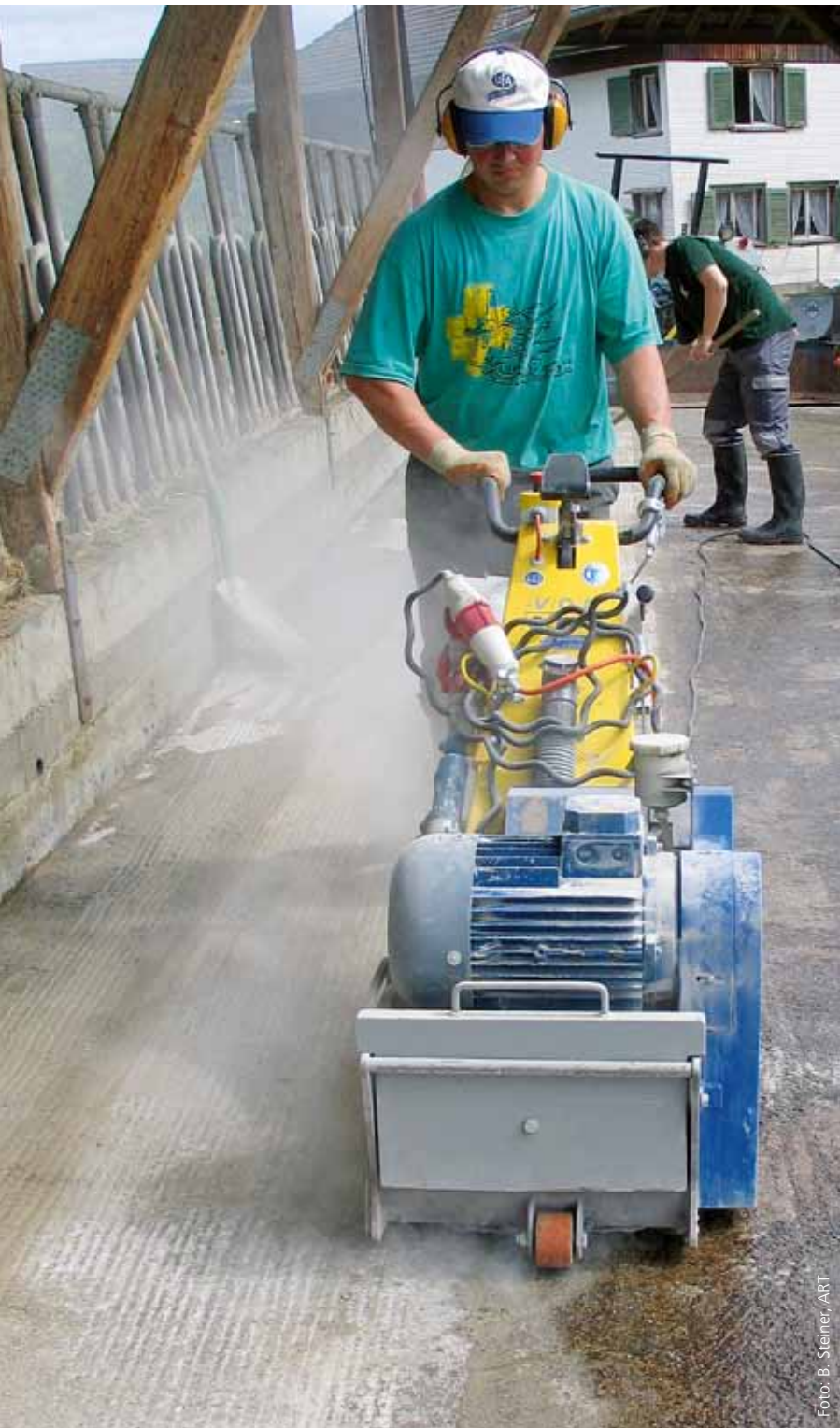
Abb. 1: Das mechanische Sanierungsverfahren «Rillieren-Aufrauen» wurde von der ART entwickelt.
