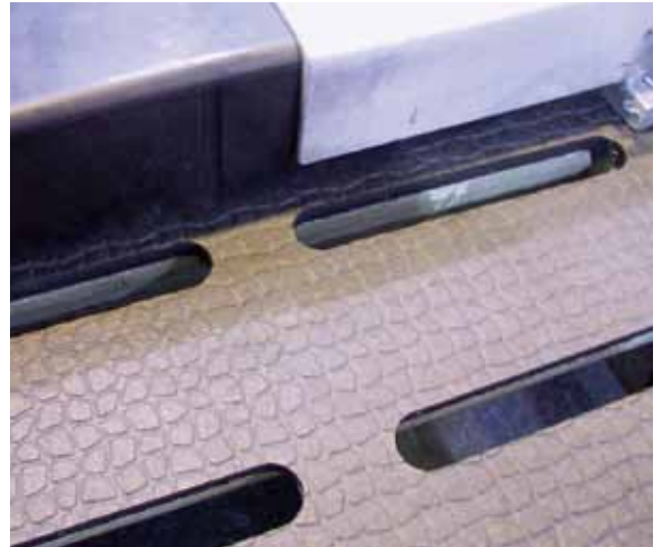
Abb. 7: Die Perforation des elastischen Gummibelags muss genau auf den Spaltenboden abgestimmt sein. Anpassungen an der Entmistungstechnik sind unerlässlich.
