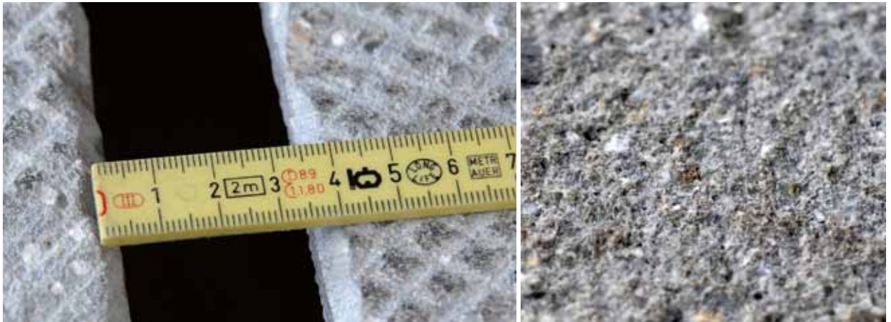
Abb. 4 und 5: Sanierungsverfahren «Rillen fräsen diagonal» mit Rundlamellen in zwei Arbeitsschritten: Mit der Nachbearbeitung der Kanten erhöht sich die Spaltenweite um ca. 5 mm (li.). Sanierungsverfahren Hochdruck-Wasserstrahl mit Strahlmittel 0,6–1 mm: Erst durch komplettes Abtragen der Kalkschichten entsteht die erforderliche Rutschfestigkeit (re.).
