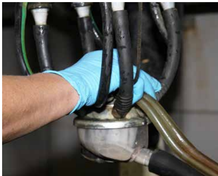
Alle milchführenden Anlagen, wie Melkanlage und Milchtank, müssen mit Trinkwasser gereinigt werden.
