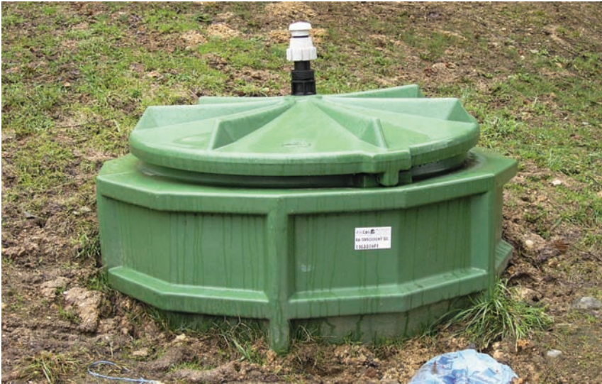
Abb. 16: Quellsammelschacht aus Kunststoff, © AGES
