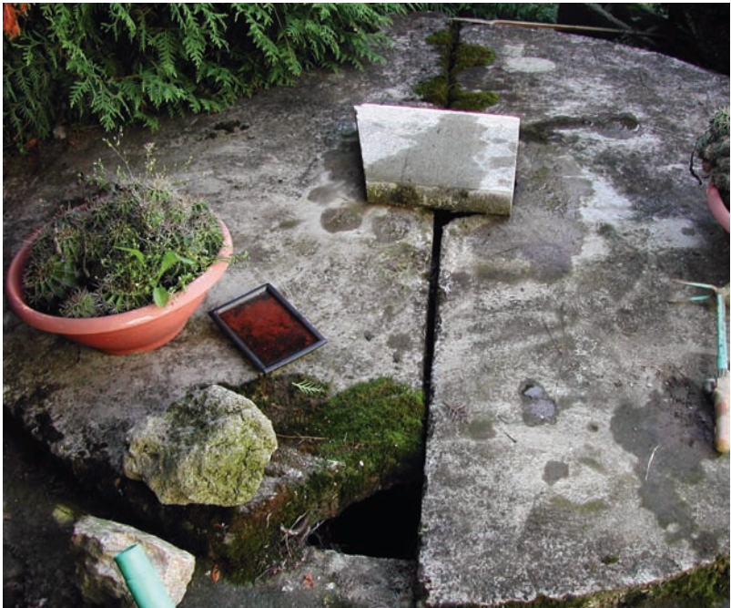
Abb. 20: So nicht! Schadhafte Abdeckung bei einem Schachtbrunnen, © AGES
