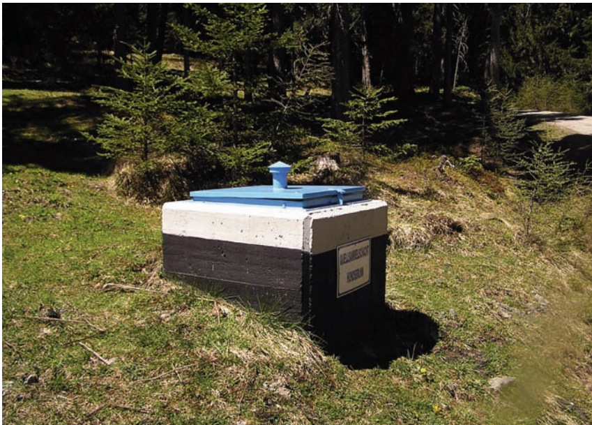
Abb. 17: Quellsammelschacht aus Beton, © AGES
