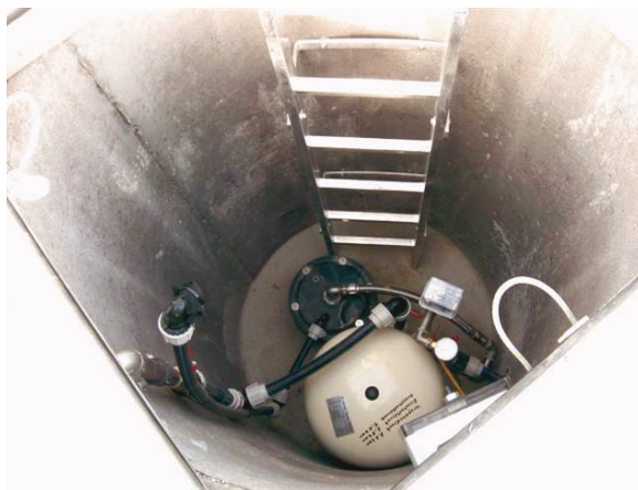
Abb. 12: Vorschacht mit Brunnenkopf und Druckerhöhungsanlage © Martin Bachner
