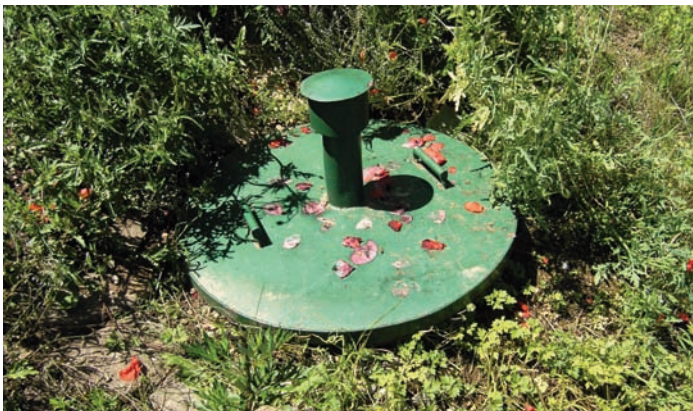
Abb. 21: So nicht! Nicht ausreichend überhöhter Schachthals, © AGES
