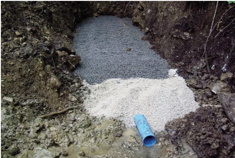
Abb. 14: Fassung einer neuen Quelle mit einem gelochten Kunststoffrohr und Filtermantel aus gewaschenem Kies, © Martin Bachner
