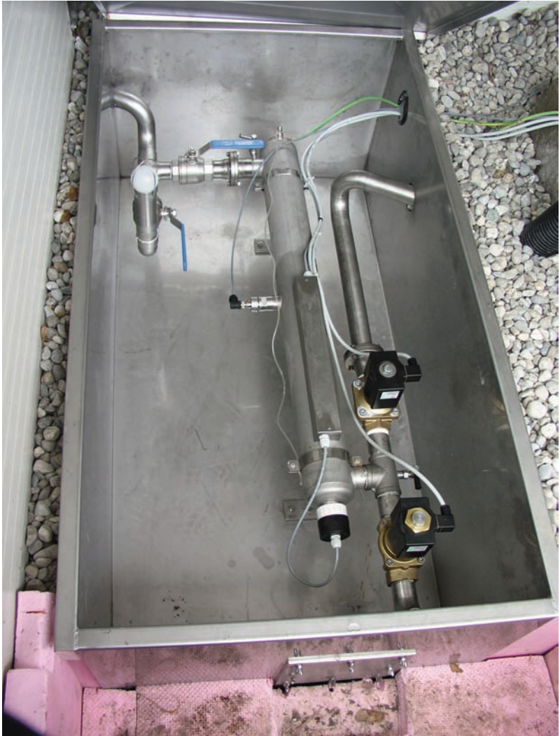
Abb.18: UV-Desinfektionsanlage © Reiter u. a., WVA (Plainfeld)
